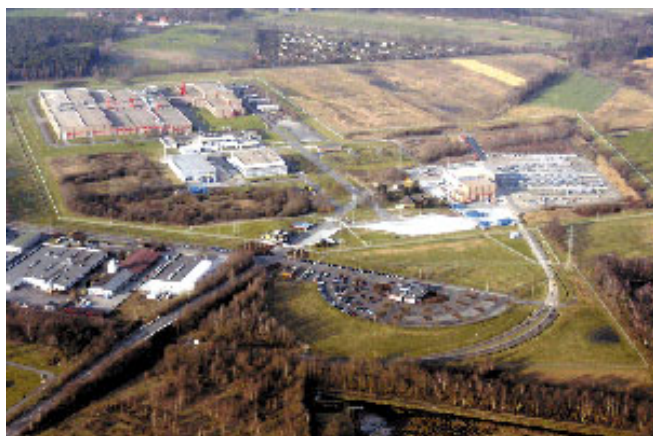
Fig. 18. Urenco Gronau, Germany. Source: kernenergie.de
