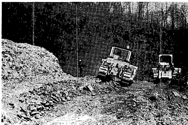
Fig. 12. Ripping PB-2.
