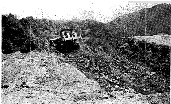
Fig. 18. Ripping PB-4.
