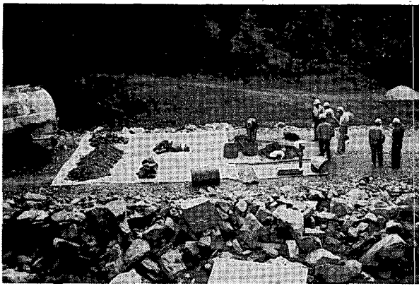
Fig. 86. Digging test pit.
